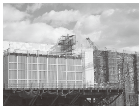
▲建物南側(右側)に構台設置中の2号機建屋
