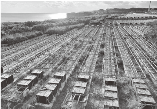
放置された太陽光パネル(手前)と多数の骨組み
