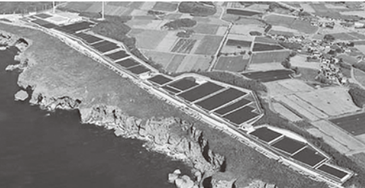
メガソーラー実証研究事業の全景(沖縄電力(株)より)
