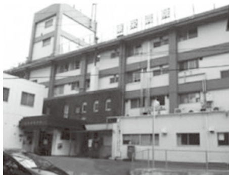
老朽した東栄医療センター
