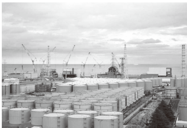
福島第一の敷地いっぱい並ぶ処理水タンク
