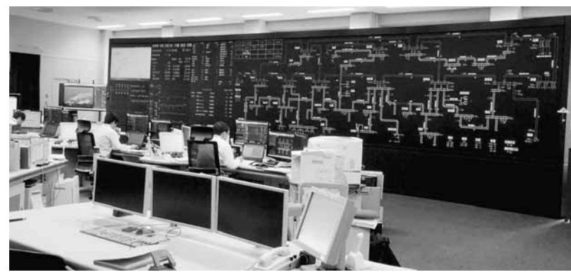
電気の使用量をもとに発電量を調整し、電気の安定供給をする中央給電指令所
